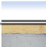
В конструкции крыш геотекстиль Fibertex используется в качестве опорного слоя, механической защиты мембран крыши, а также как защитный фильтр дренажного слоя.
