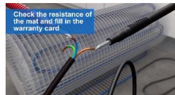
Монтаж нагревательного мата Uponor Comfort E
